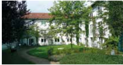
Altenhilfezentrum Fritzlär Reinhold-Koch-Haus (II)
