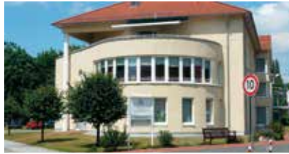
Wohnpark Am Töpferdamm (II)
