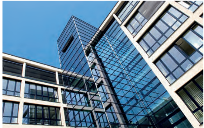
Büro CFB-Fonds 147 Haus der Wirtschaftsförderung, Saarbrücken
