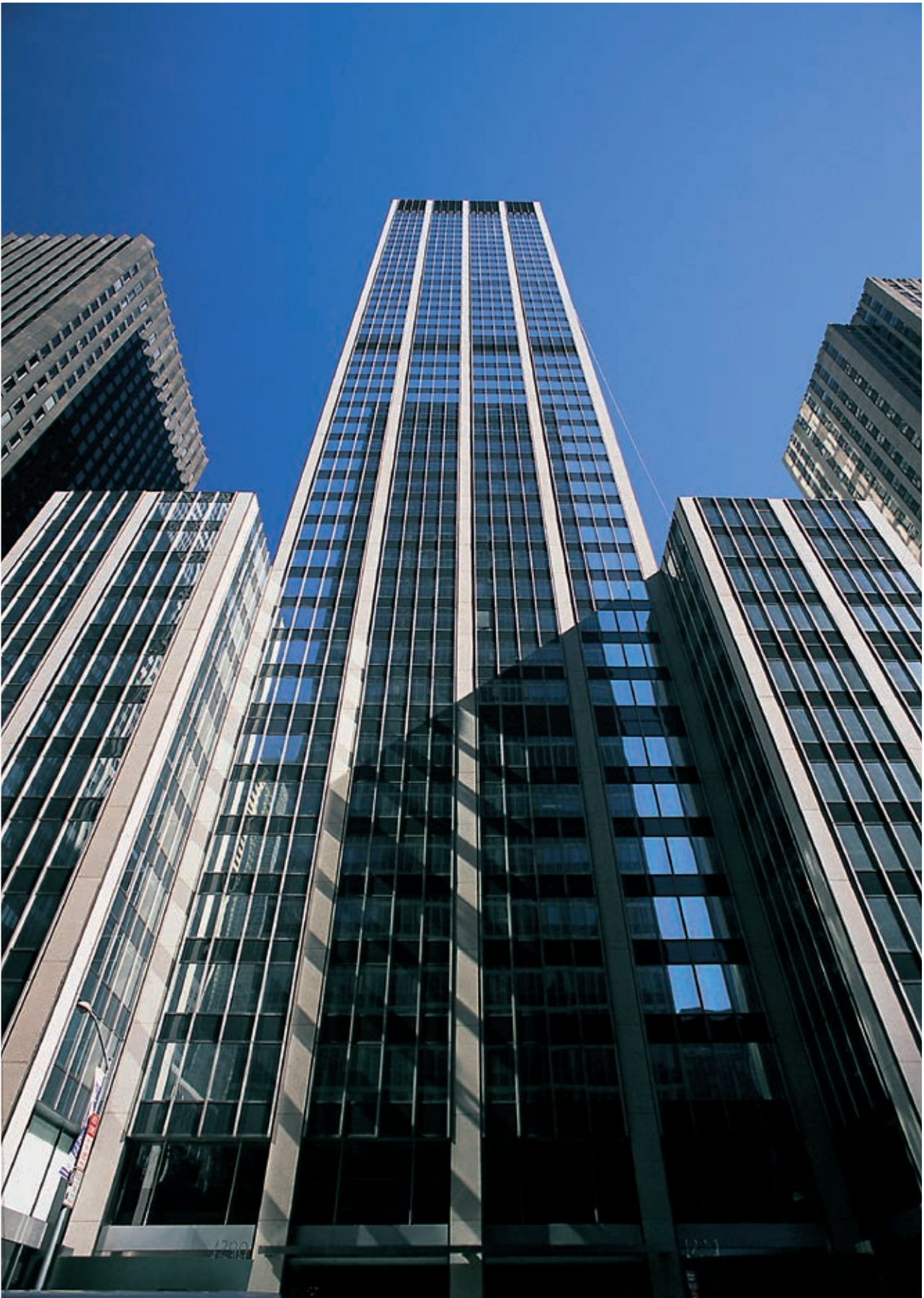
Bürohochhaus 1290 Avenue of the Americas, Büroturm in Midtown Manhattan, New York, NY Baujahr: 1963 Mietfläche in qm: 183.565 Verkauft am 27.04.2006
