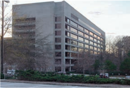
IBM-Bürogebäude, 4111 Northside Parkway, Atlanta, Georgia Baujahr: 1978/1987 Mietflächen in qm: 72.899 verkauft am 02.05.2011
