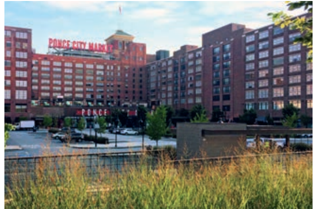
Ponce City Market, 675 Ponce de Leon Avenue, Atlanta, Georgia, USA Mietflächen in qm: 100.000 zzgl. 256 Mietwohnungen Vermietungsstand: 95%
