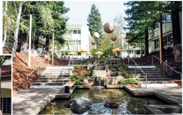
Bürokomplex Larkspur, 700, 900, 1100 Larkspur Landing Circle Larkspur, Kalifornien, USA Mietflächen in qm: 18.492 Vermietungsstand: 95%
