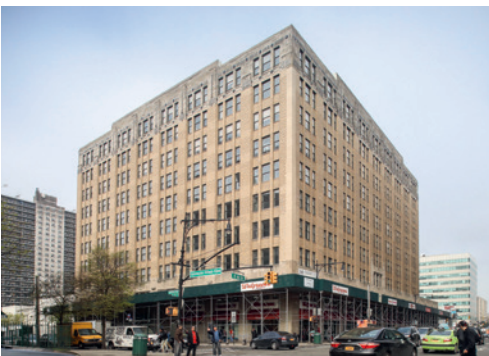
Büro- und Geschäftsgebäude 260 East 260 East 161st Street Bronx New York, New York, USA Mietflächen in qm: 24.718 Vermietungsstand: 75%
