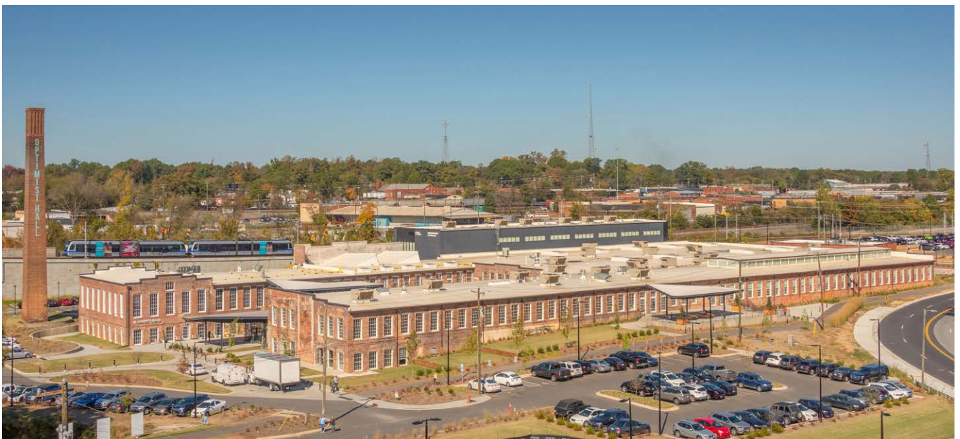
Büro- und Einzelhandelsimmobilie Optimist Hall 317-340 East 16th Street und 1101-1128 North Brevard Street Charleston, North Carolina, USA Mietflächen in qm: 12.045 Vermietungsstand: 94%
