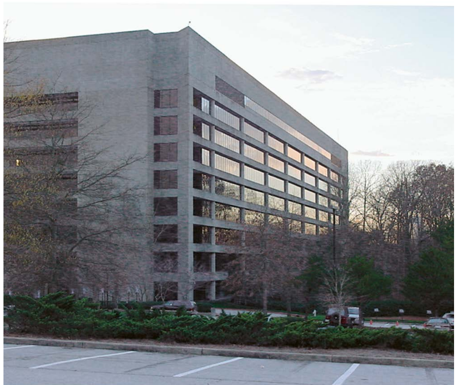
IBM-Bürogebäude, 4111 Northside Parkway, Atlanta, Georgia Baujahr: 1978/1987 Mietflächen in qm: 72.899 verkauft am 02.05.2011
