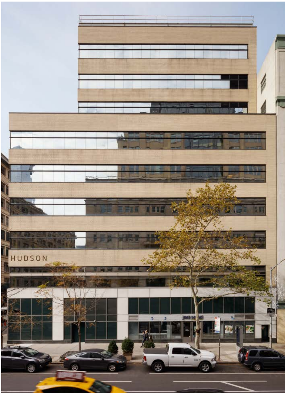
Bürogebäude 325 Hudson Street, 325 Hudson Street, New York City, New York, USA Baujahr: 1930/1965 Mietflächen in qm: 22.427 Verkauft am 20.05.2021
