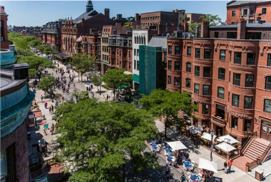
Einzelhandelsportfolio Newbury Street, Newbury Street und Boylston Street, Boston, Massachusetts, USA Mietflächen in qm: 20.360 zzgl. 50 Mietwohnungen Verkauft am 27.11.2018
