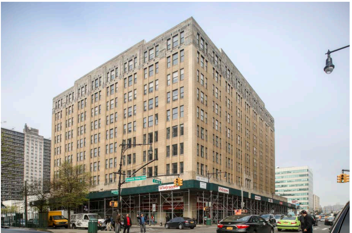
Büro- und Geschäftsgebäude 260 East 260 East 161st Street Bronx New York, New York, USA Mietflächen in qm: 24.718 Vermietungsstand: 100%
