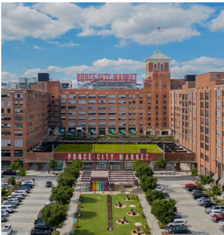
Bestandsgebäude Ponce City Market
