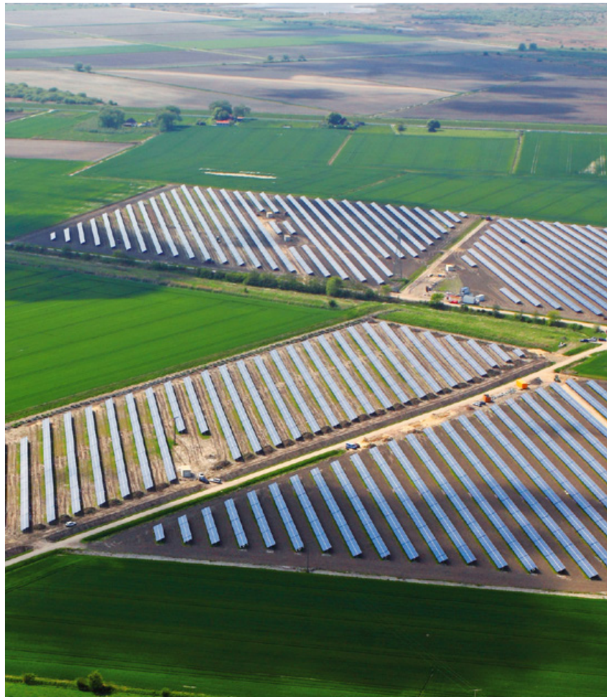
Meldorf – Anlageobjekt SOLARENERGIE NORD
