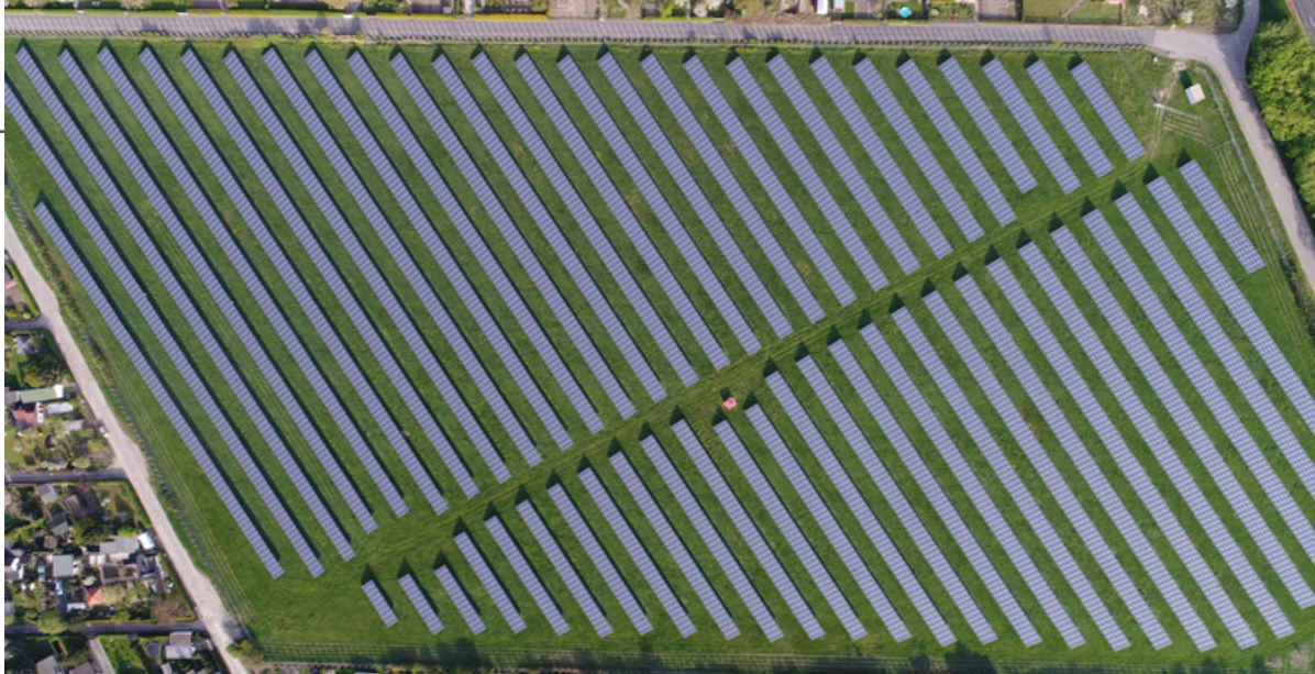
Torgau – Anlageobjekt SOLARENERGIE 3 DEUTSCHLAND
