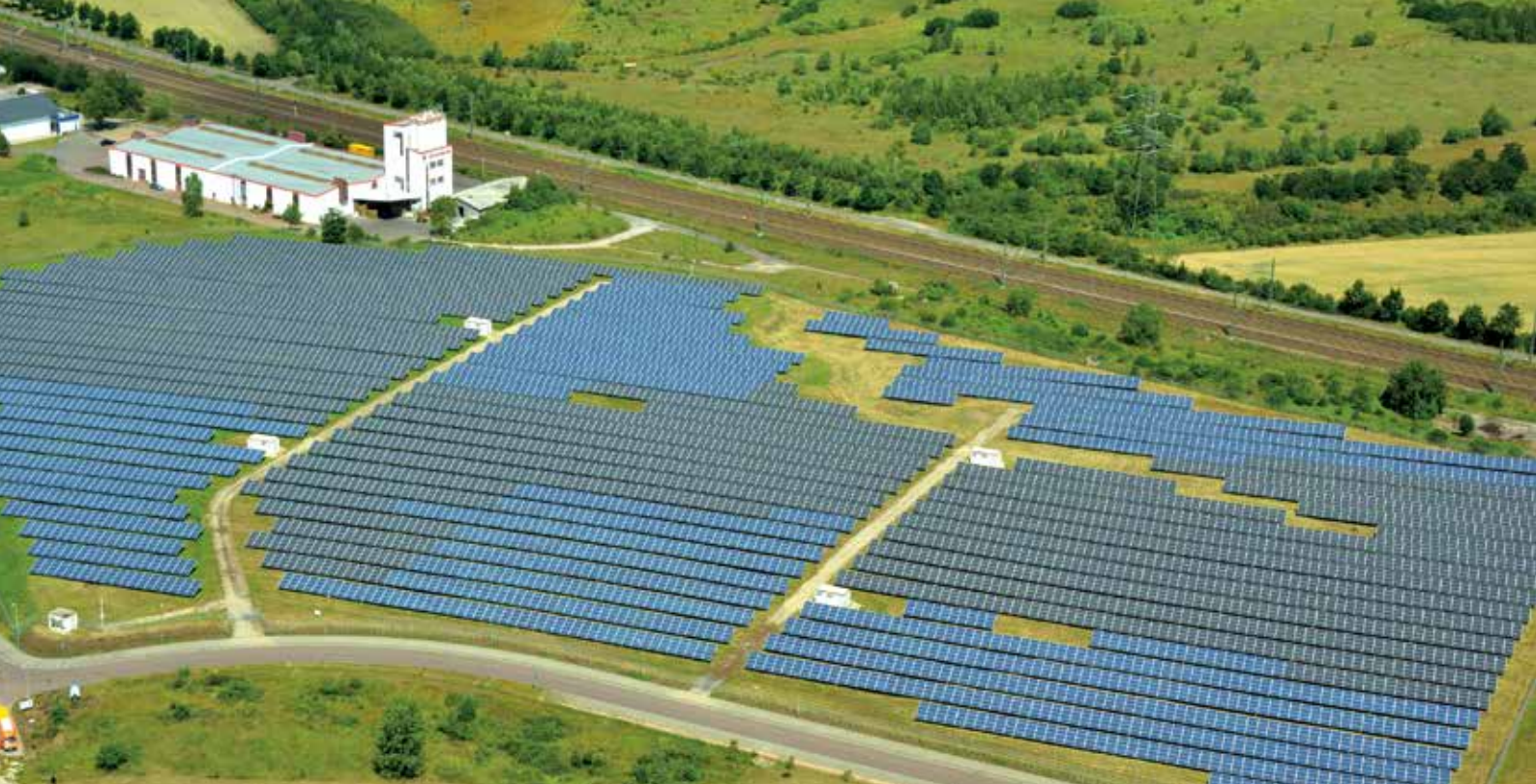
Solarpark Halle – Anlageobjekt Solarenergie 3 Deutschland
