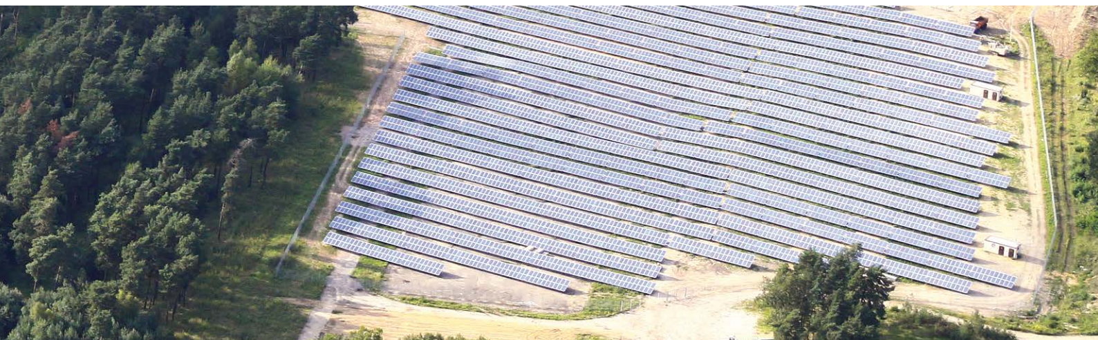
Solarpark Königsbrück – Anlageobjekt SOLARENERGIE 2 DEUTSCHLAND
