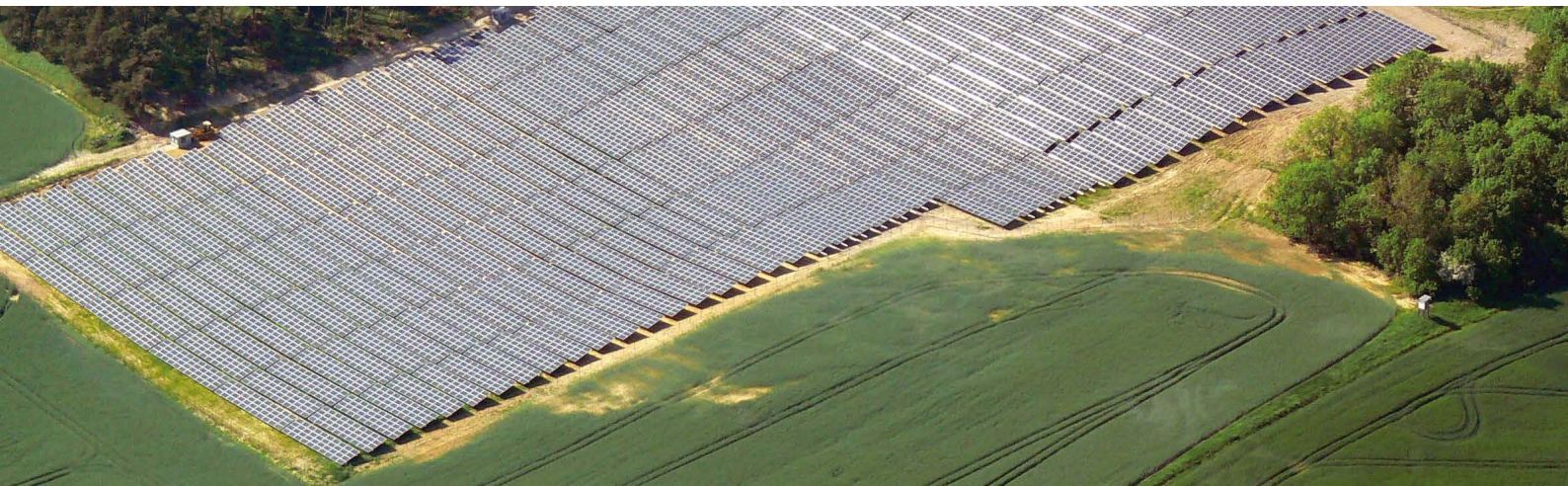
Uckermark – Anlageobjekt SOLARENERGIE 3 DEUTSCHLAND
