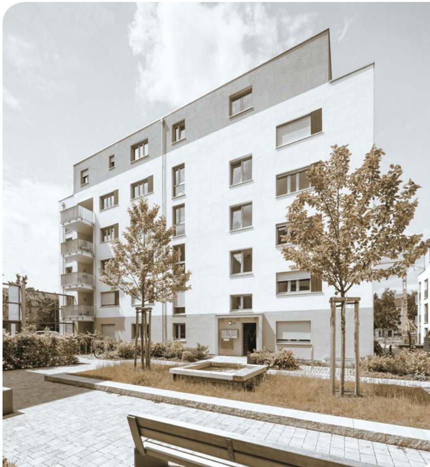
Objekt Herrnstraße 45, Fürth Südstadt
