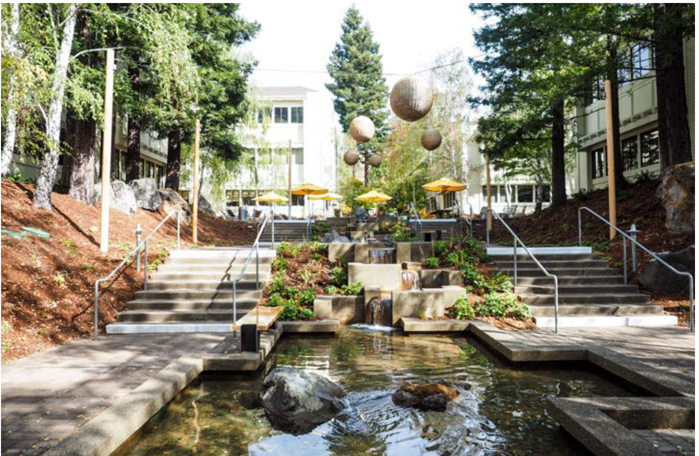
Bürokomplex Larkspur, 700, 900, 1100 Larkspur Landing Circle Larkspur, Kalifornien, USA Mietflächen in qm: 18.492 Vermietungsstand: 94%
